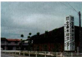
北桑木材センター(京都市右京区京北)
